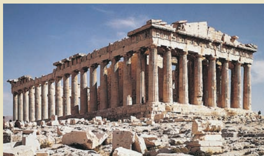
C. Partenonul, templul monumental de pe Acropola ateniană. După cum se observă, este construit în stil doric. Arhitecții care au proiectat acest templu sunt Ictinos și Calicrates. Se mai observă elementul constructiv în formă de triunghi ridicat deasupra coloanelor. Acesta se cheamă fronton.
