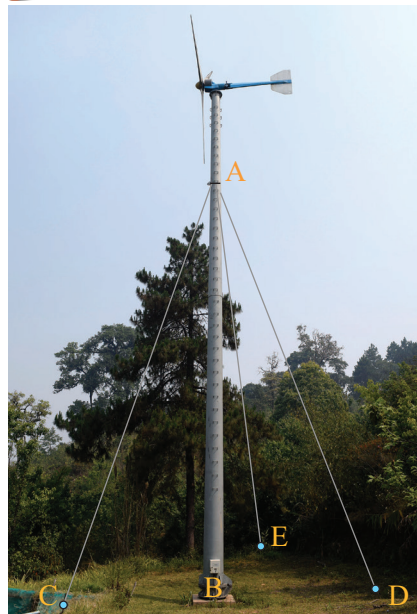
Figura 17 – Stâlp pentru turbina eoliană
