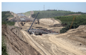
Tăierea versanților pentru construcția autostrăzii Cernavodă - Constanța
